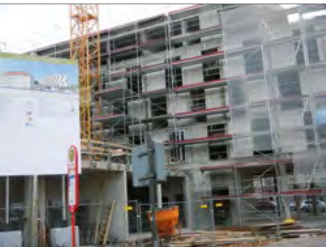
Die Bauarbeiten für das neue Arcona-Living-Hotel in Osnabrück gehen gut voran.
